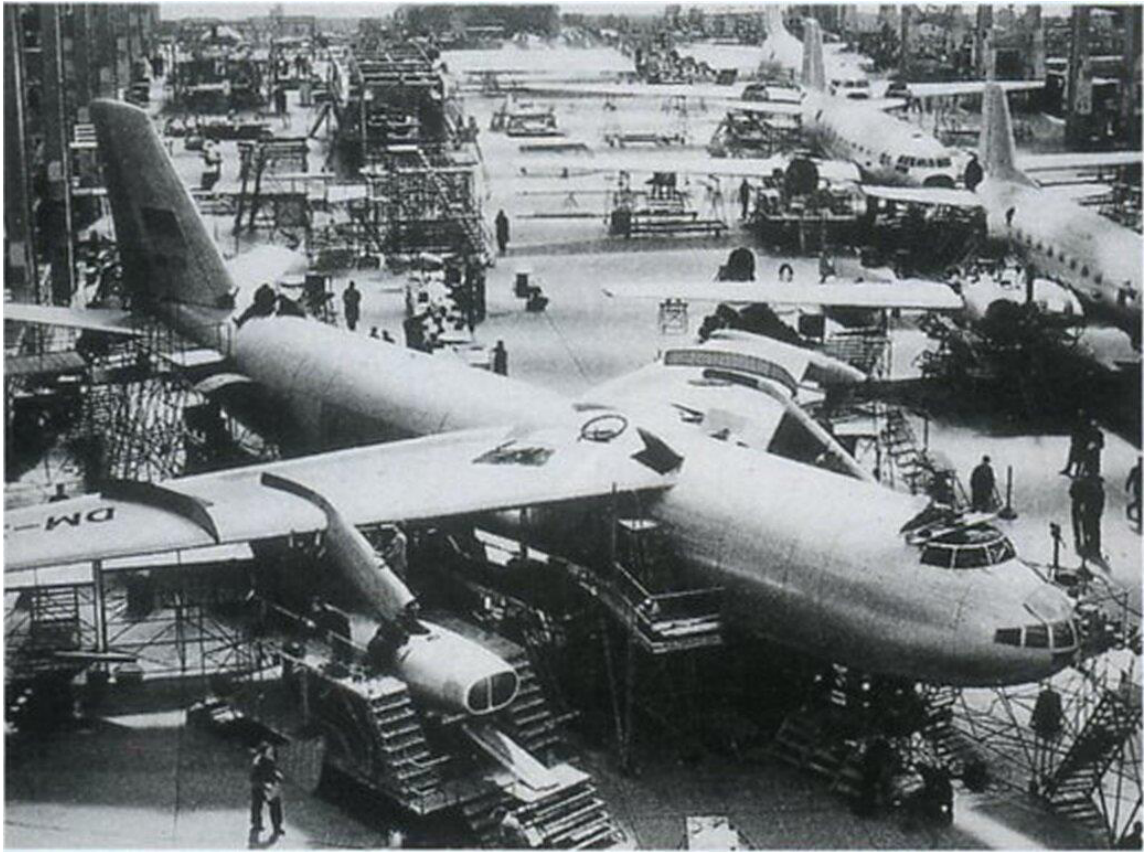
Первый прототип «152» V1 в сборочном цеху дрезденского авиазавода
