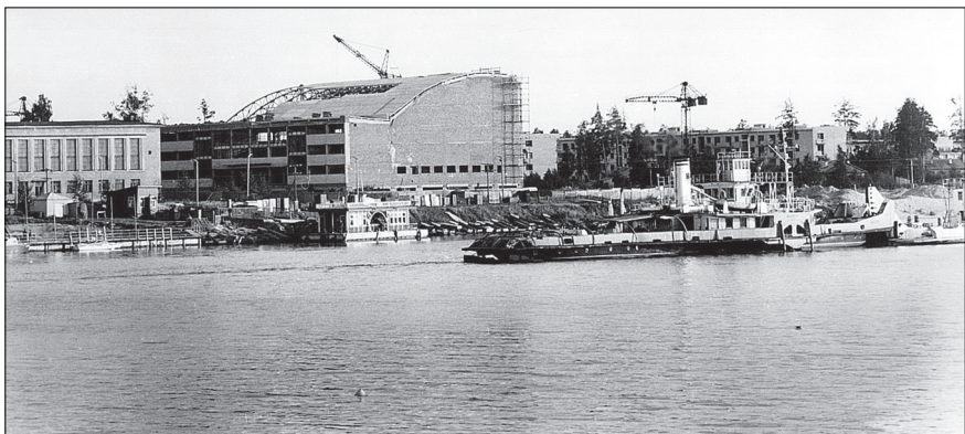
Бассейн «Архимед» строится
