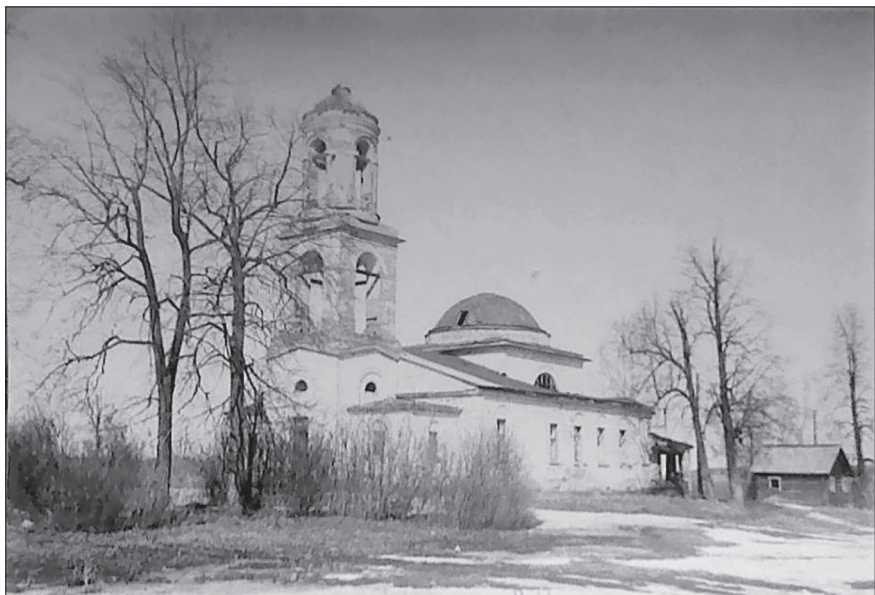
Разрушенный храм в д. Ратмино
