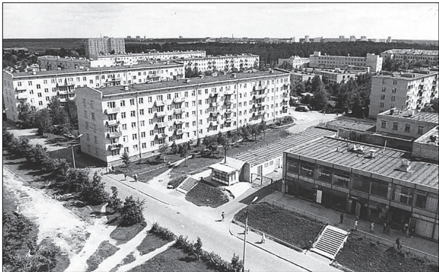
Дома по ул. Центральной. Застройка 1970-х гг.
