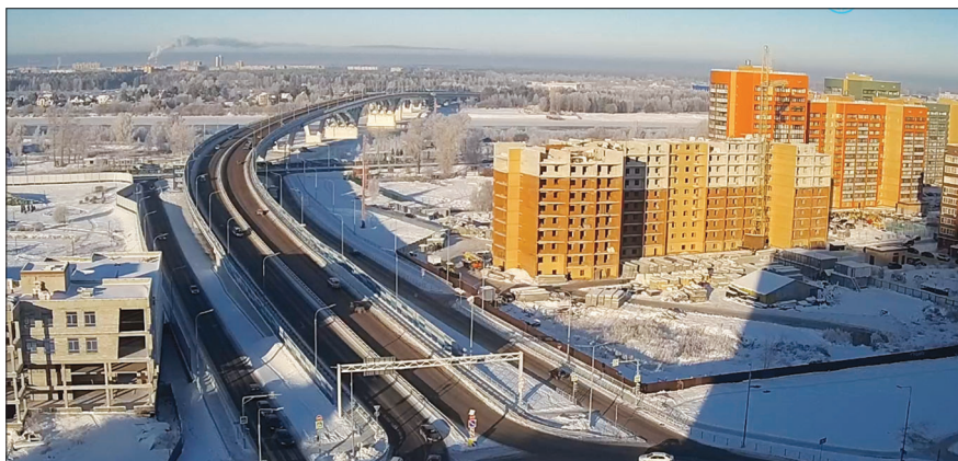
Строительство моста. 2017 г.
