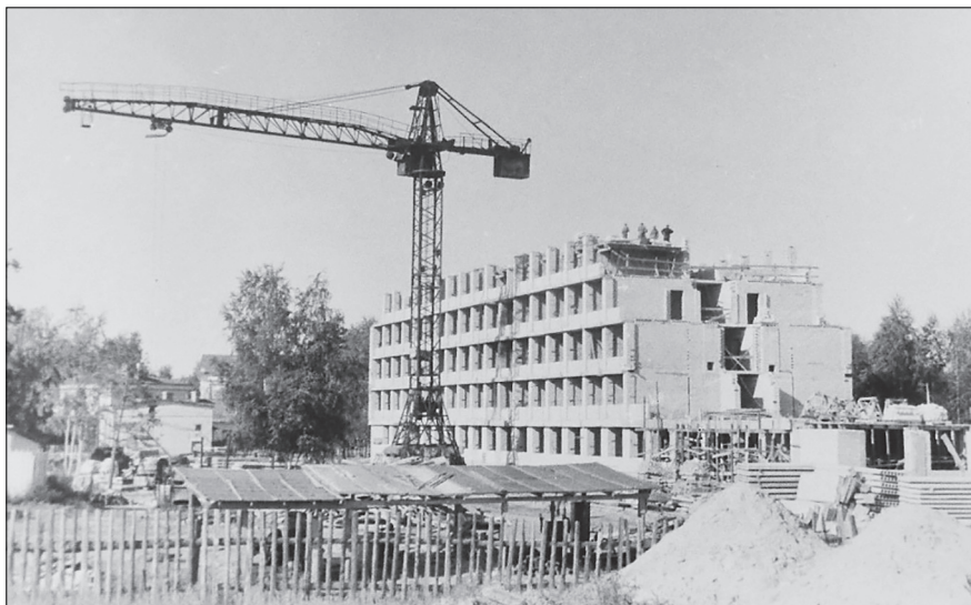
Строительство гостиницы «Дубна». 1962 г.
