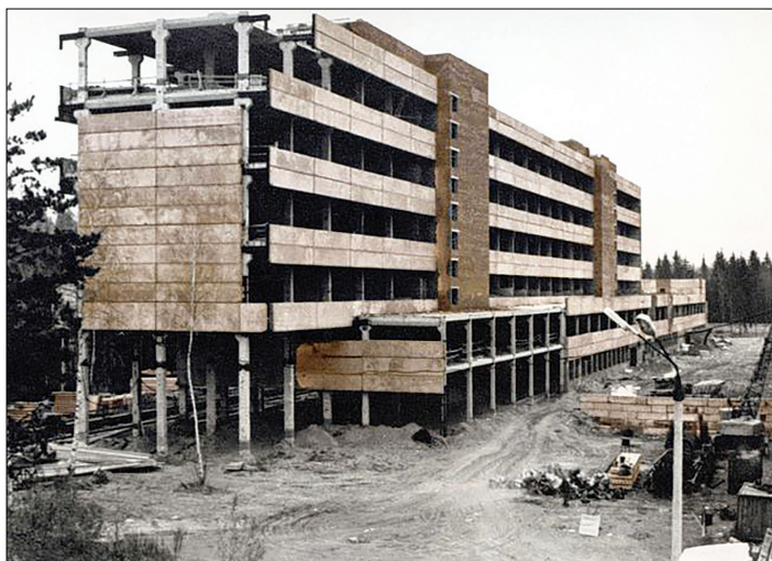
Строительство НИИ «Атолл»
