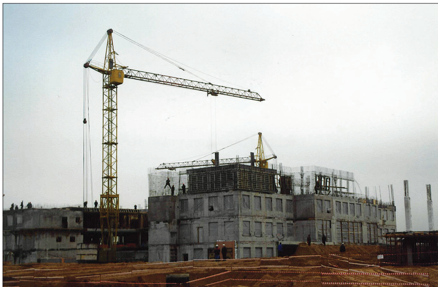
Начало строительства конгресс-центра в ОЭЗ «Дубна». 2007 г.
