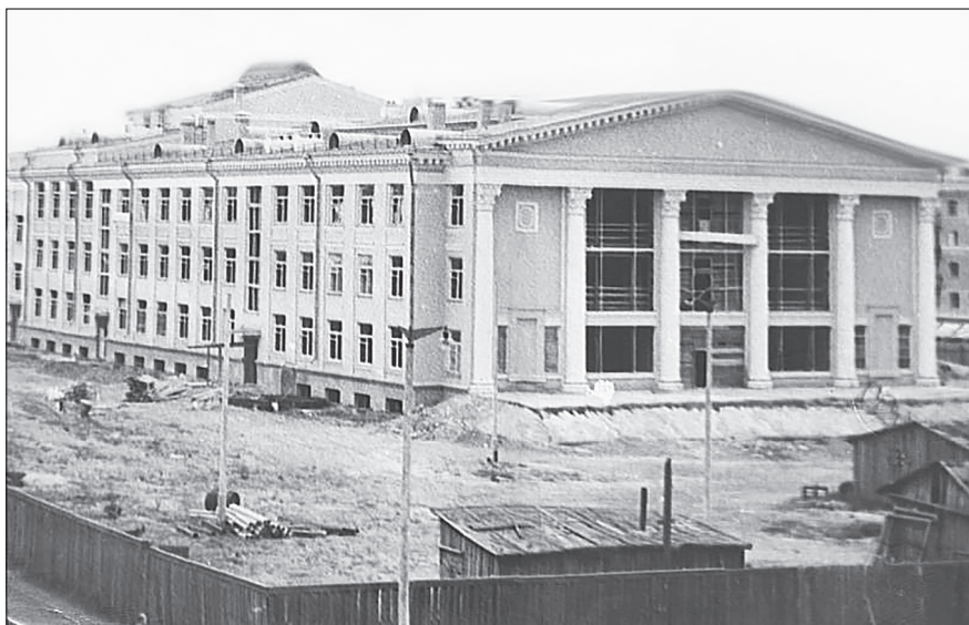
Строительство ДК «Октябрь»
