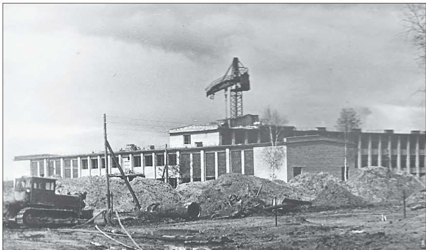
Школа № 8 строится. 1960 г.
