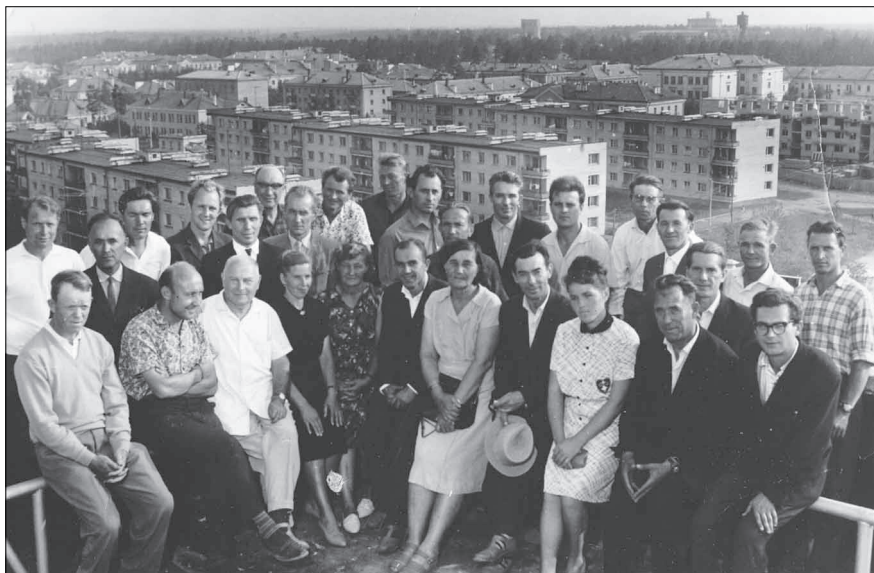
Строители первого в городе 10-этажного дома. 1965 г.
