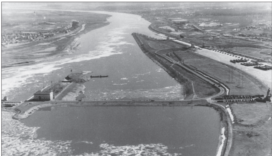
Панорама гидросооружений Волжского района
