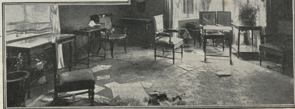
Общій видъ разрушенной дачи министра — съ фасада.
