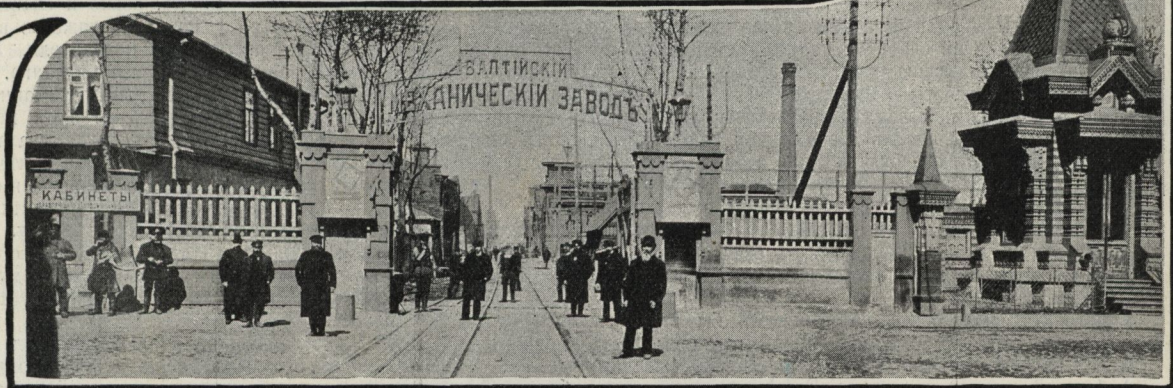
Входныя вѣрты. Рельсовый путь желѣзной дороги, обслуживающей заводъ.
