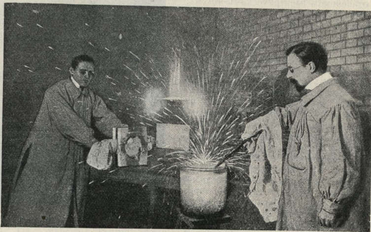
Погружение в холодную воду накаливавшегося в печи тигля.
