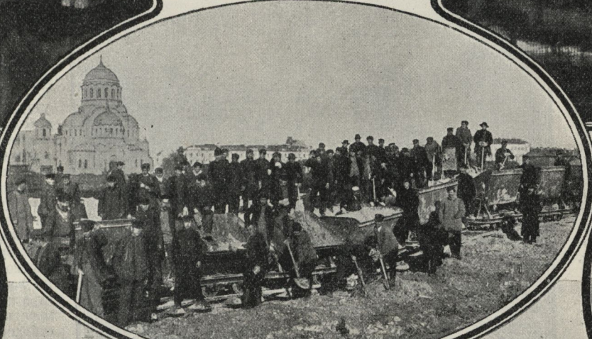
Наполненіе вагонетокъ землею для подсыпки Галерной гавани.
